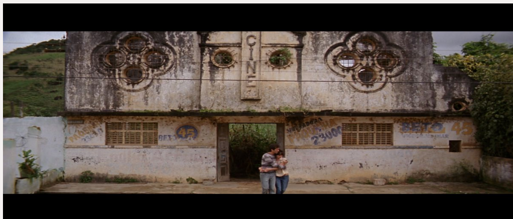
Imagem 2: Cinema em ruínas.
