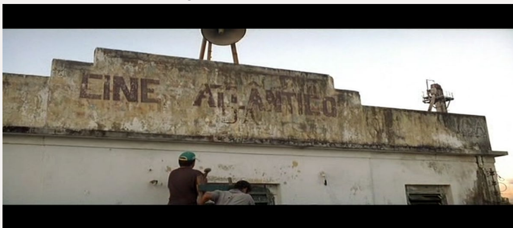
Imagem 1: A demolição do Cinema.
