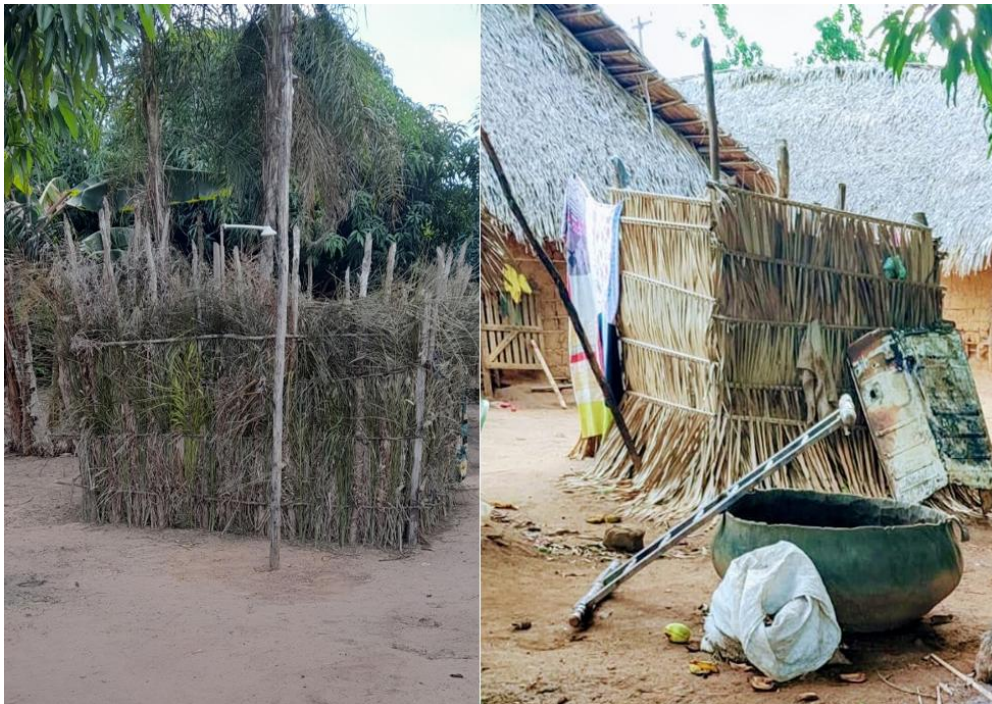
Figura 7: Banheiros ao ar livre construídos com palhas de “tucum” e de “babaçu”. Buriti Bravo-MA
