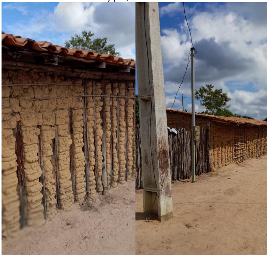
Figura 5: Casas cobertas de telhas, paredes de barro e cerca de madeira “do mato”. Aldeia Guajajara, Barra do Corda-MA
