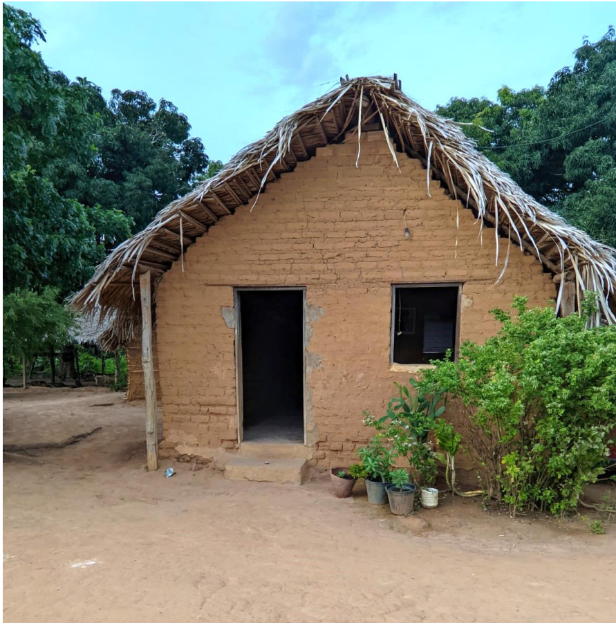
Figura 2: Casa coberta de palha, parede de “adobe” e terraço em chão de barro batido. Buriti Bravo-MA
