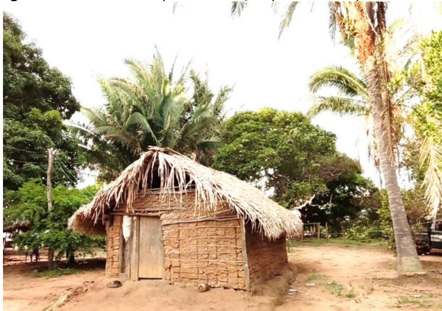
Figura 1: Casa coberta de palha de babaçu e parede de “taipa”. Buriti Bravo-MA
